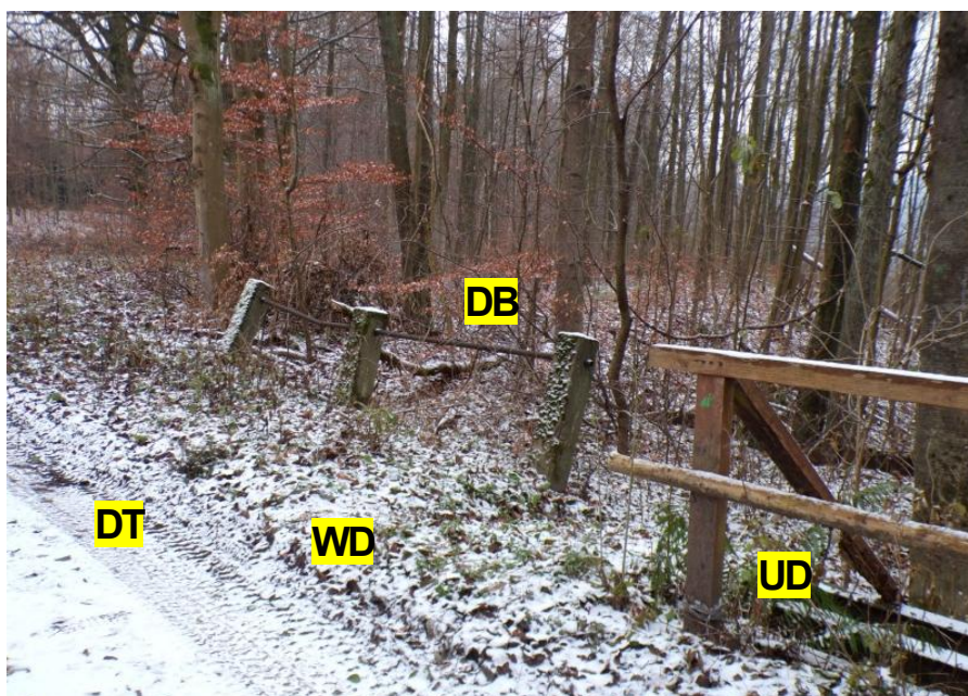
Fot. 3. Widok na teren przy drodze od strony południowej – nawierzchnia gruntowa skoleinowana – zawyżone pobocze utrudnia odwodnienie – obsunęła się skarpa na dojeździe wraz z balustradą
