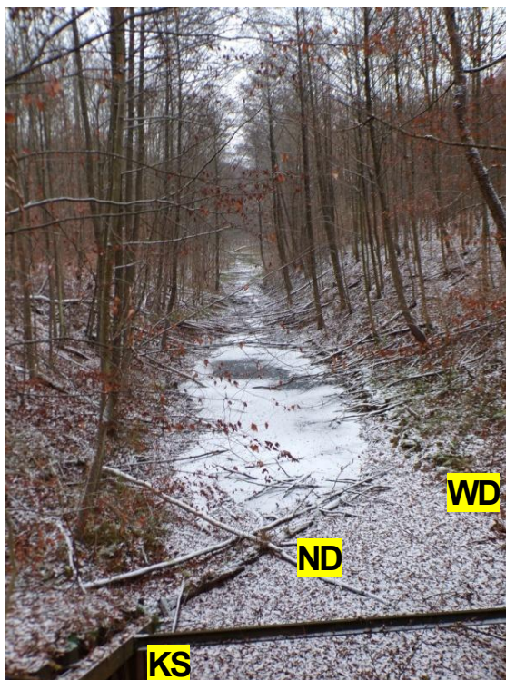
Fot. 5. Widok na koryto rzeki od wylotu: – niski stan wody, koryto ulega powolnej naturalizacji – końce skrzydeł wylotu są stabilizowane ramą rozporową
