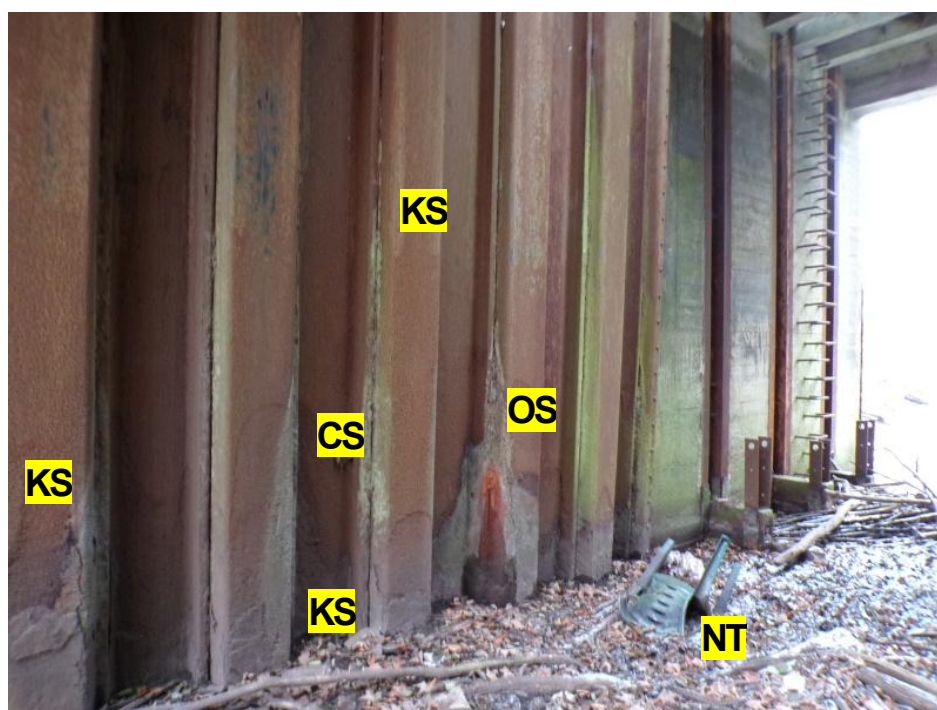
Fot. 12. Widok na strefę połączenia ścian wylotu z grodzic i ściany służą z przewodnikami – ubytki korozyjne ścianek grodzic przy dnie wynoszą 5-7 mm, lokalnie występują perforacje – zanieczyszczenia organiczne i bytowe w korycie
