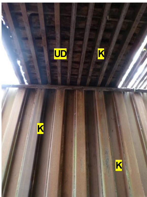
Fot. 13. Widok na ściankę stalową podpory w miejscu oparcia przęsła z 11 szt. belek I280 – ogólna korozja stali grodzic oraz rusztu stalowego przęsła
