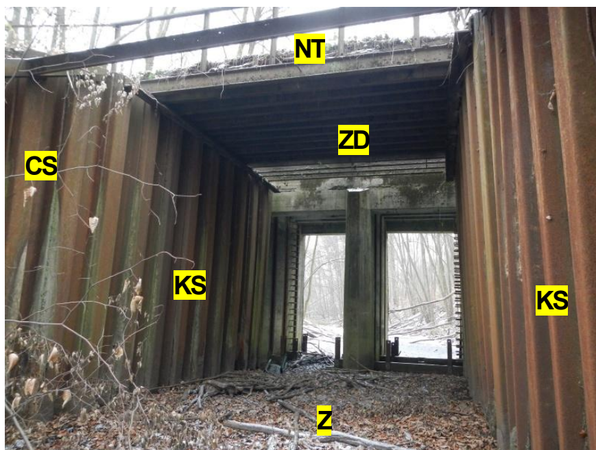
Fot. 14. Widok ogólny ścian wylotu, w tle ściany nieczynnej śluzy: – korozja powierzchniowa i wżerowa grodzic, (90 lat eksploatacji w agresywnych gruntach rodzimych – namuły/torfy) – występują duże przecieki na zamkach – ścianki stalowe zbiegają się górą ku sobie
