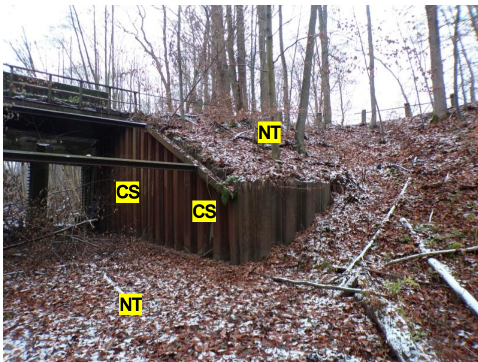
Fot. 9. Widok na zakończenie skrzydła przyczółka od wylotu – silna korozja podpór i ram rozporowych skrzydeł – naturalizacja skarp grobli, humus przesypuje się przez głowice ścianek
