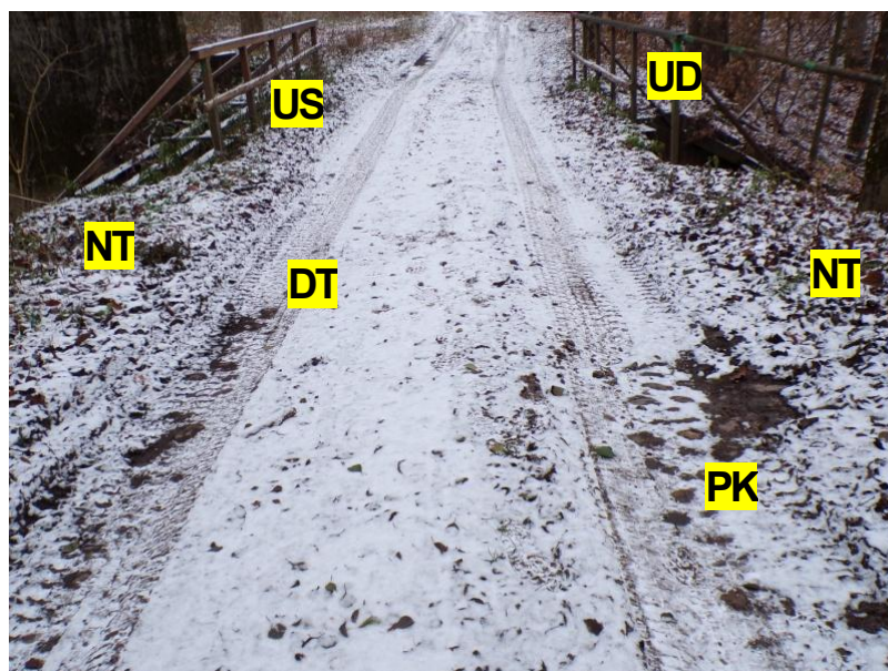
Fot. 6. Widok na południowy dojazd do mostu – za odcinkiem przejściowym nawierzchnia brukowcowa – zawyżone pobocza utrudniają odwodnienie kolein
